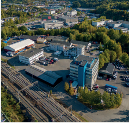
1) Alna Park (Strømsveien 221-223 og Breivollveien 13), 12 900 kvm
